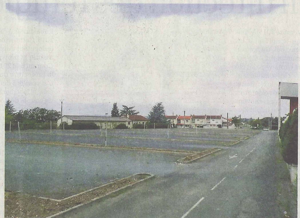
Le parking du Forum a été dégagé pour permettre le début des travaux. /Photo DDM, J-C C
